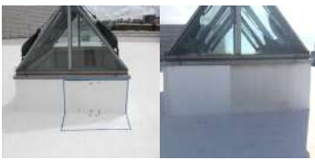
鹿児島水族館:高反射遮熱塗装の防汚 (火山灰対策)
