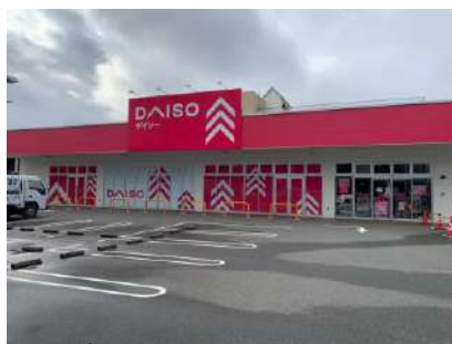
ダイソーの 全国1200店舗施工 (継続中)
