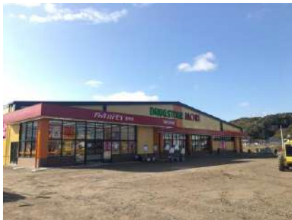
ドラッグストアモリ 新店100店舗施工(継続中)
