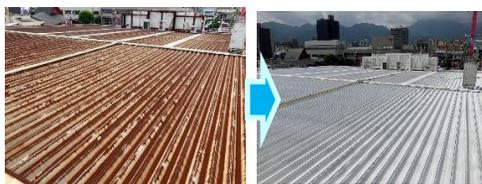
今回提案するRM断熱シールドとは、折板屋根、プレハブ建物向けに、防水、防錆塗装と、遮熱、断熱塗装を一緒にした画期的なコートシステムです。これまでの防水塗装は、シーラー、ウレタン塗装2回、トップコートの4工程、断熱塗装は、シーラー、断熱塗装2回と別々の塗装業界だったものを、今回、ラストメート+省エネカバーコートの工程で対策できます。
