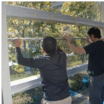
スポンジバー工法
