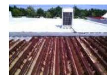
これまでの防さび、防蝕業界の常識を覆す、画期的な防錆コートです。プライマーなしの一発コートで、大幅な施工工程を減らすことができます。4種ケレンで錆の上からコートでき10年以上の防さび効果を実証しています。
