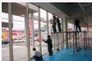
建物は、断熱性能が一番の問題です。特に開口部の窓ガラスは、夏は73%入り、冬が58%窓から熱逃げします。幸神住宅向けには、LOW-Eペアガラスよりも遮熱、断熱性能が高い冷暖ガラスシールド・1㎡15000円、法人建物向けには、IRUVシールドSP1㎡12,000円で対策できます。一回のコートで15年の耐候性があります。
