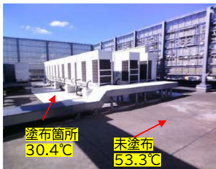
【遮熱塗装した床面と未塗布の床面の比較 温度差22.9°C】
