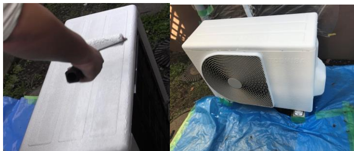
省エネカバーコート施工
