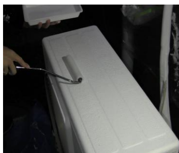
スーパーガラスバリア施工
